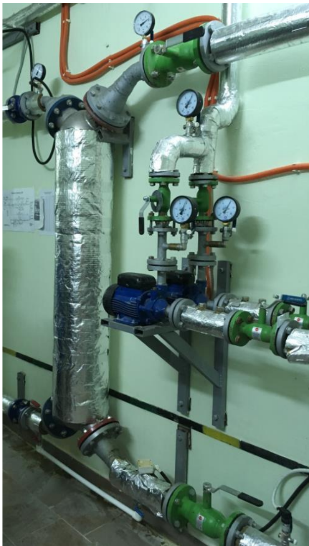
Рисунок 9. Элементы схемы ИТП на базе кожухотрубных теплообменных аппаратов
